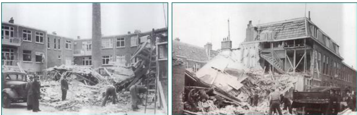
Figuur 77: Schade na de bominslag op 29 oktober 1940 in de Ripperdastraat. (Bron: bijlage 3, BAL, pag. 148-149).
