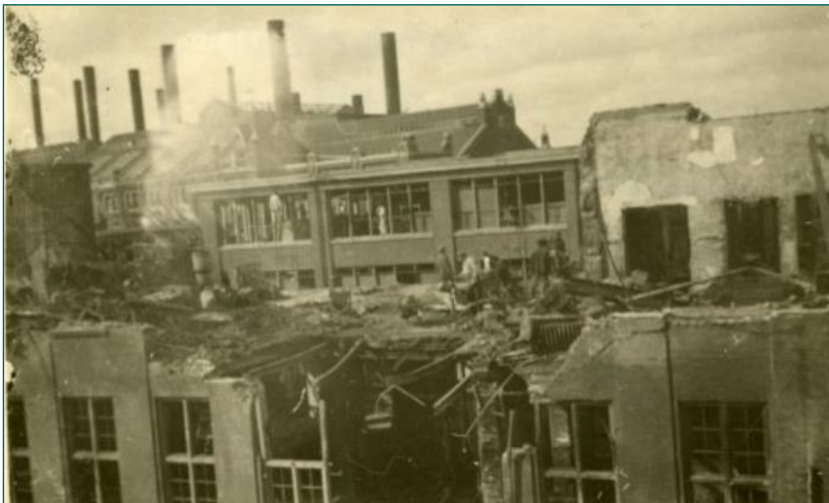
Figuur 151: Foto d.d. 4 mei 1943. Schade aan het Telefoongebouw. (Bron: Haagse Beeldbank).
