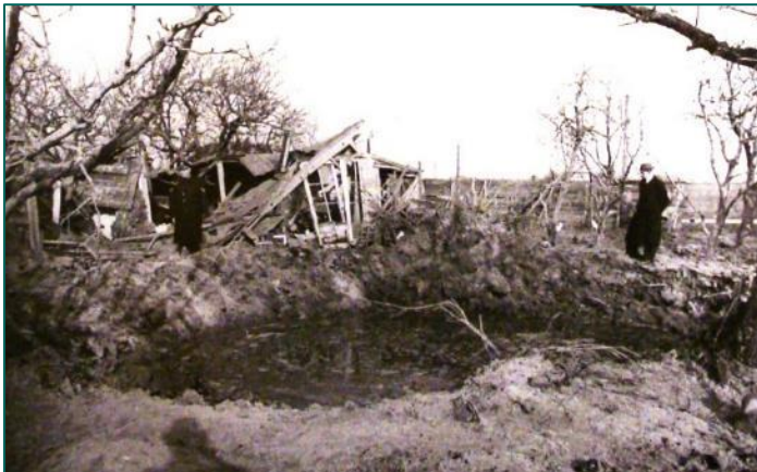
Figuur 83: Schadebeeld naar aanleiding van een op 8 november 1940 neergekomen bom. (Bron: bijlage 4, toegang 1165-01, inv. 101).
