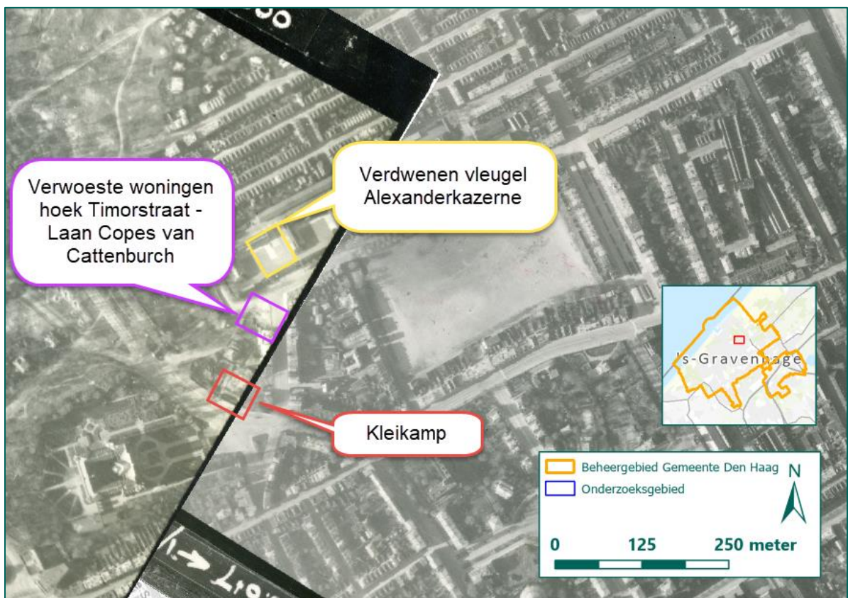
Figuur 162: Zichtbare schade op de luchtfoto d.d. 7 april 1945. (Bron: Wageningen UR).
