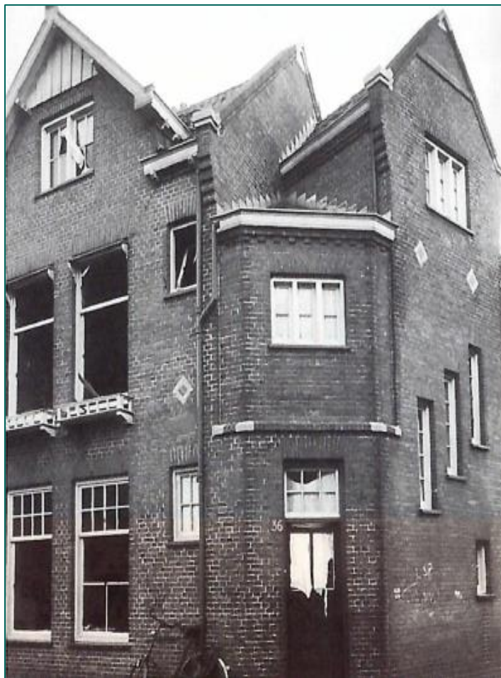
Figuur 91: Schade aan Reepstraat 36. (Bron: bijlage 3, BAL, pag. 138.
