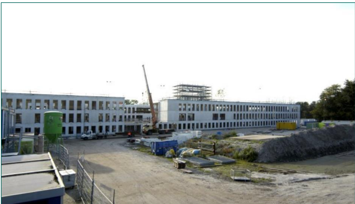
Figuur 322: Wijndaelerlaan. Bouwplaats Internationale school, 17 oktober 2005. (Bron: Haagse Beeldbank).
